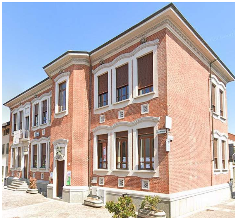
IMMAGINE DELL'EDIFICIO A SERVIZIO DELLA SCUOLA ELEMENTARE DI VAUDA CANAVESE.
