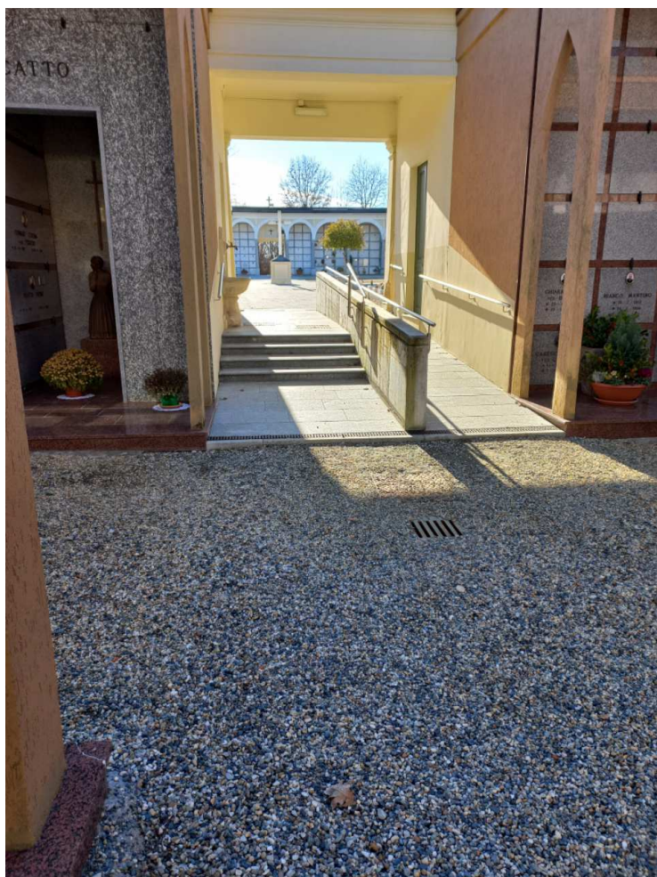
Area da pavimentare Zona Ampliamento Nord
